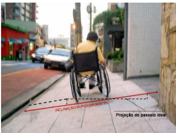
Figura 10 – Passeio com inclinação incorreta – com mais de 3%.
