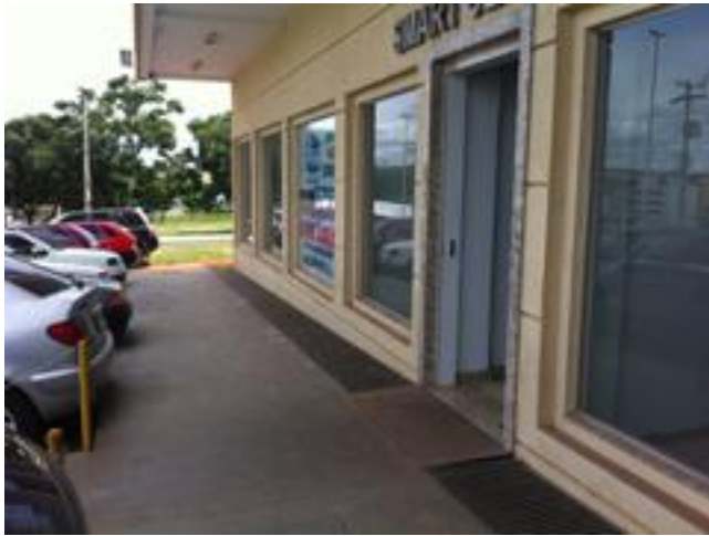
Passeio acompanhando a inclinação do meio-fio.
