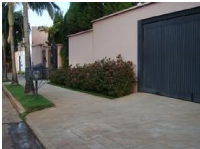
Figura 06 – Calçada composta pelas 3 faixas: Faixa de Serviço, Faixa do Passeio, e Faixa de Acesso ao Lote.
