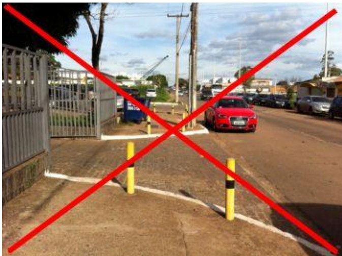
Figura 13 – Acesso de veículos com rebaixamento do passeio não permitido.
